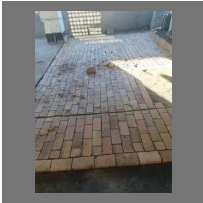
A. R. Tiles Lining Work
